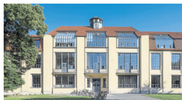
Hauptgebäude der heutigen Bauhaus-Universität in Weimar von Henry van de Velde.
